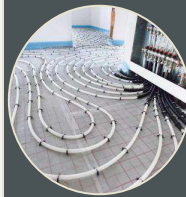
Neues Heizungskonzept - Heizen durch Fußbodenheizung
